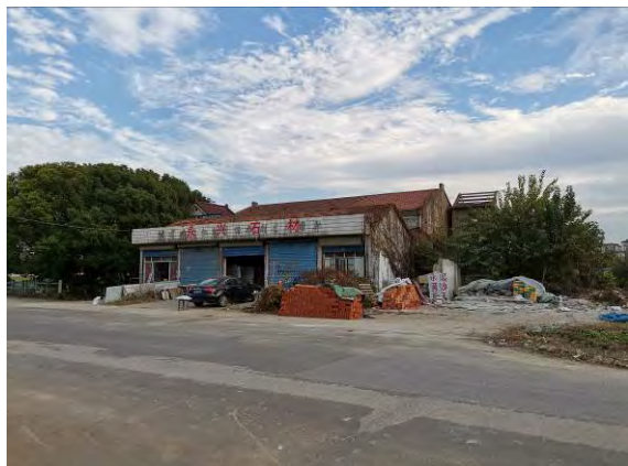
（待拆除构筑物）
