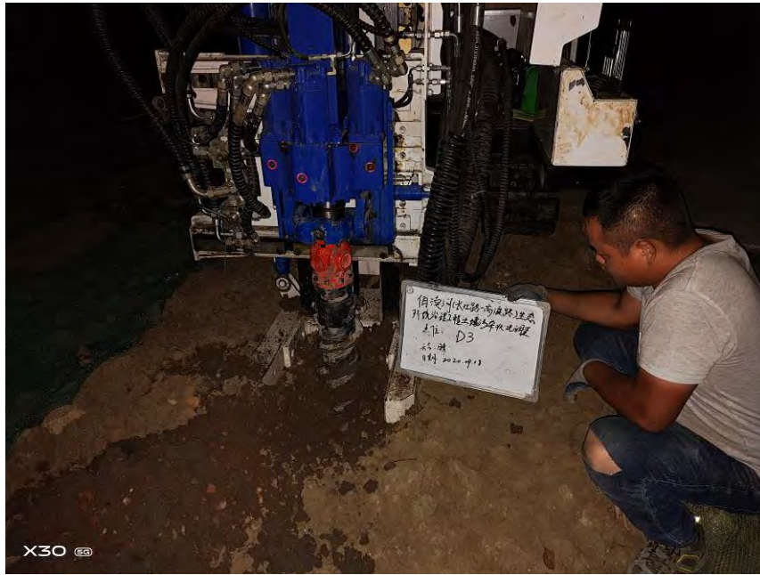
图 6.1-3 钻孔
