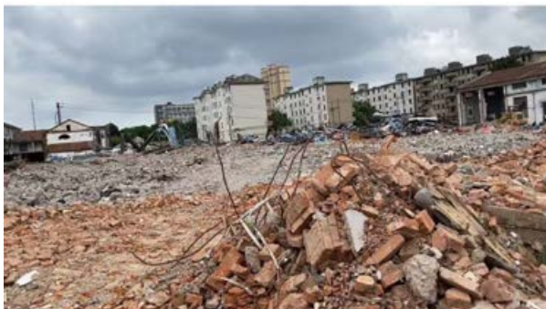
图 2.4-2 无锡市力衡称重设备有限公司所在区域现状实拍图（2021 年 1 月）
