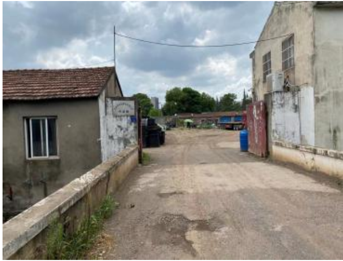
图 2.4-5 无锡市旺交储运有限公司所在区域现状实拍图（2021 年 1 月）
