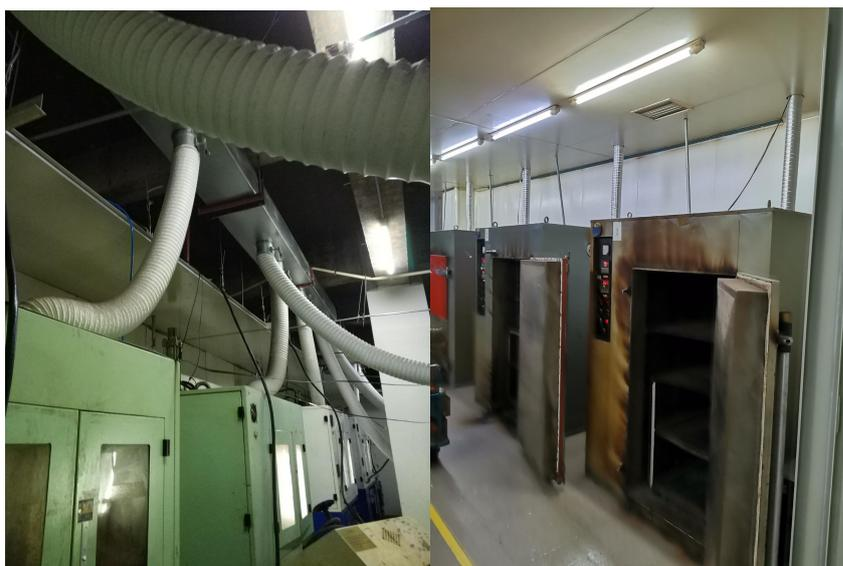
图 9-2 塑封压机、烘箱废气收集示意图
