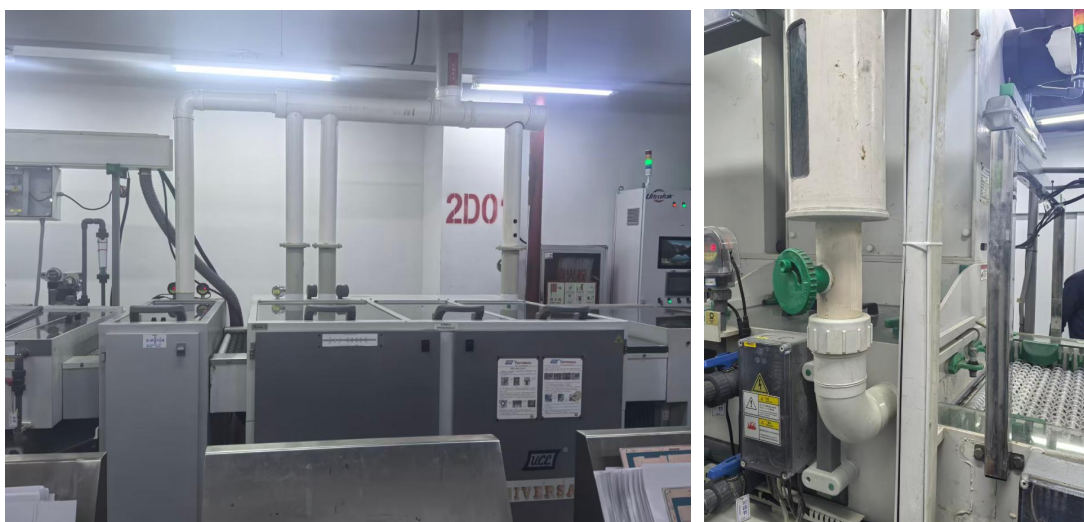
图 4-2 废气全密闭收集措施示意图
